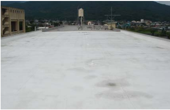
手前の白い部分が施工範囲
