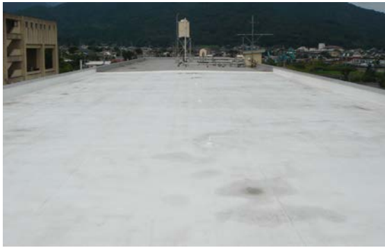
手前の白い部分が施工範囲
