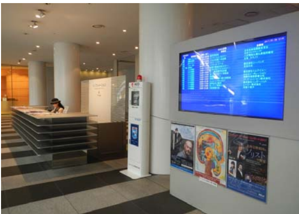
(電光案内板 1, 6階設置)
