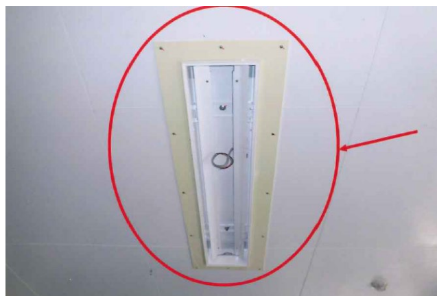
③ LED照明器具取付
