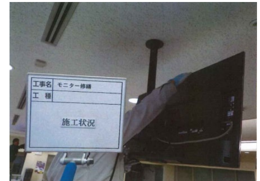
新設モニター施工状況
