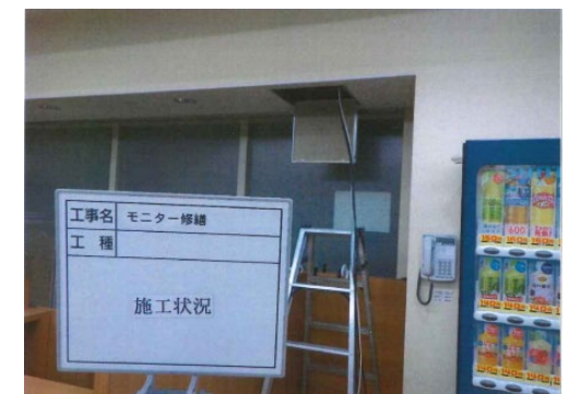
新設モニター配線状況
