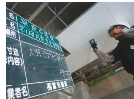
天井化粧石膏ボードの取付け
