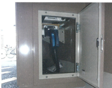
マンション1階の駐車場の一つにEV充電設備を設置
