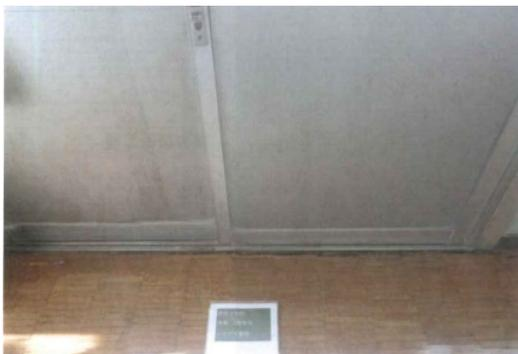
教室の床にきしみや空洞などシロアリの被害が確認された
