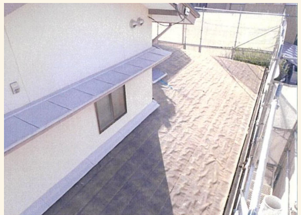
瓦と瓦棧を撤去します。
