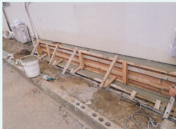
型枠を設置しコンクリートを打設します。
