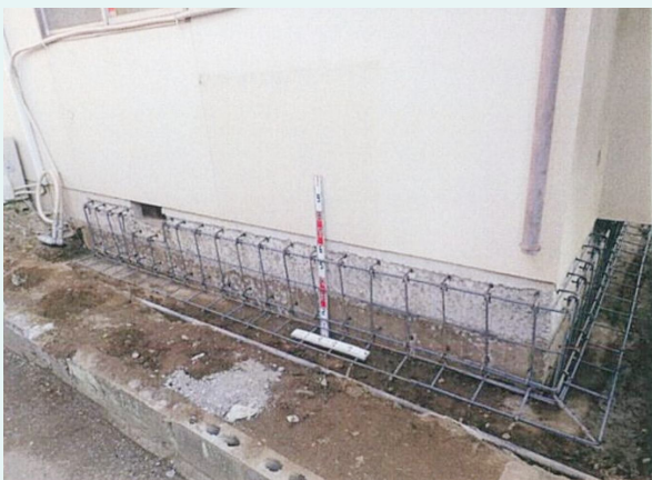
コンクリートを目荒らしして配筋します。
