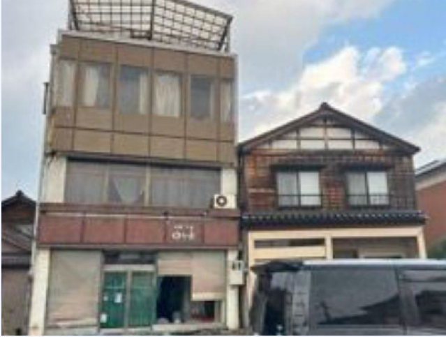
隣家と衝突した可能性がある住宅
