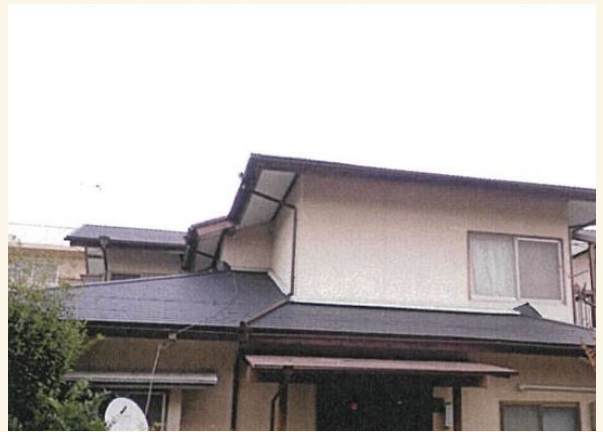
工事後のスレート葺きの屋根です。 重量が軽くなるので建物の負担が小さくなります。
