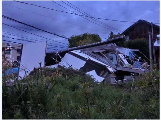
1回目の地震で壁が外れた木造住宅(左)が、2回目の地震で倒壊した(右)した例
