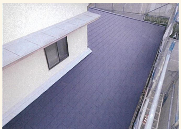
ルーフィングとスレートを設置します。
