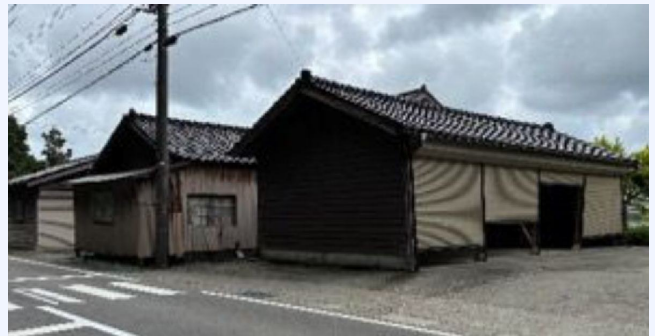
2023年地震時に倒壊を免れた家屋(2023年撮影)
