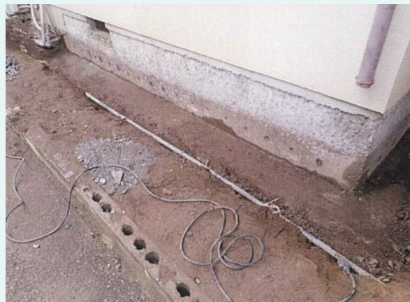
補強する部分の土を掘削します。
