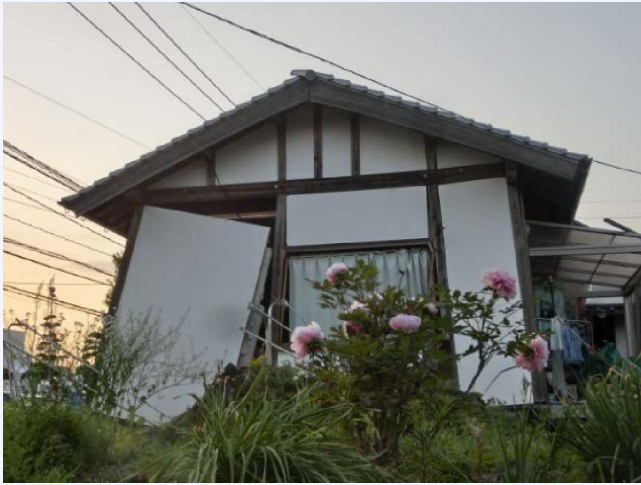
1回目の地震で壁が外れた木造住宅(左)が、2回目の地震で倒壊した(右)した例
