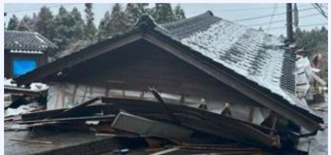
2023年地震時に倒壊を免れたが倒壊に至った家屋
