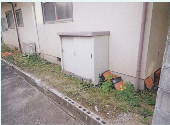
工事前の状況です。
