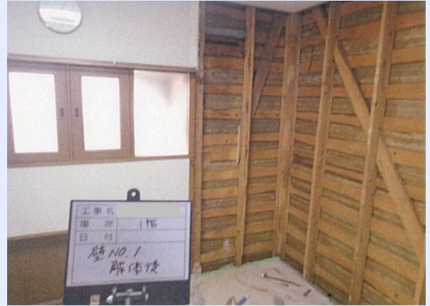
仕上げを撤去します。
