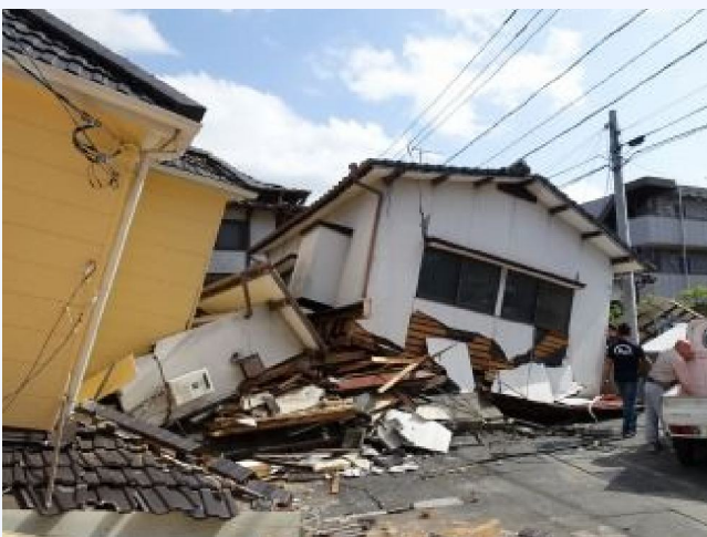
倒壊した木造住宅
