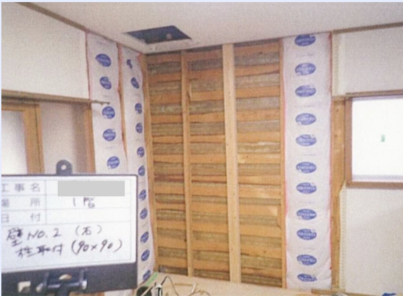
耐震パネル設置のため柱を新設します。
