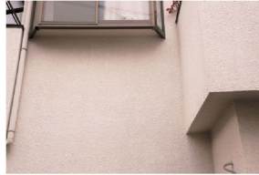
健全な外壁（ひび割れ等がない）
