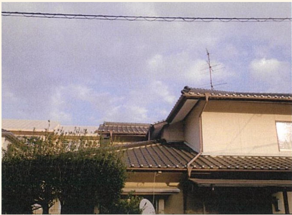
工事前の瓦葺きの屋根です。
