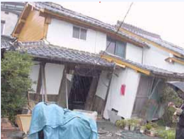
1階の傾斜が著しい建物
