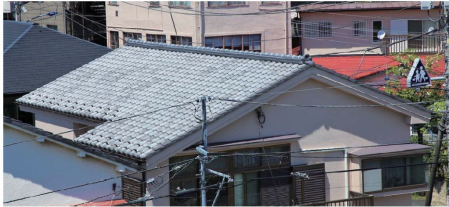
健全な瓦屋根
