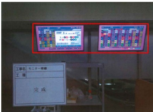
新設モニター完成
