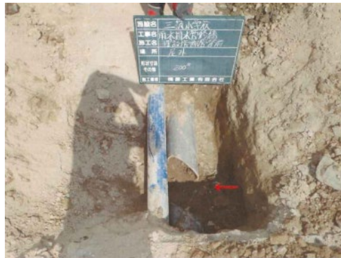
不良個所の掘削及び確認
