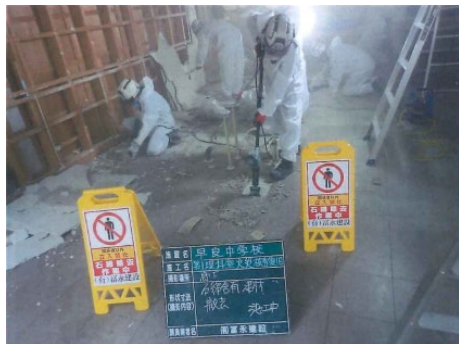
アスベスト含有の床材撤去
