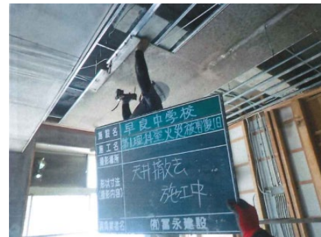
天井材の撤去
