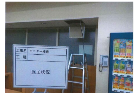
新設モニター配線状況
