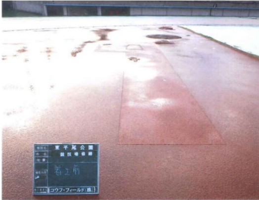
グラウンドコートの不良に伴う部分修繕
