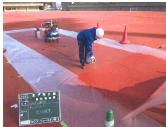
トップコートの吹付け
