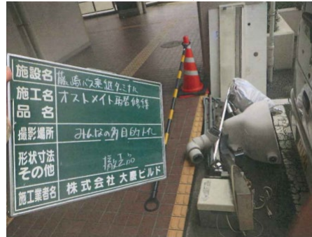
既設オストメイト撤去
