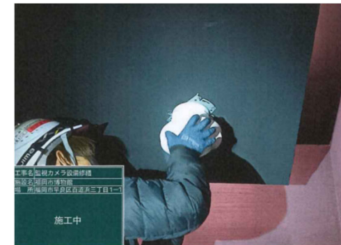
新設カメラ施工状況
