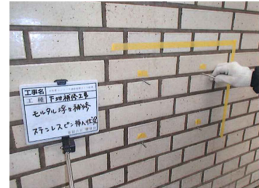
ステンレスピンを挿入
