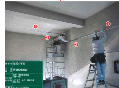
照明器具取付のための 配管設置
