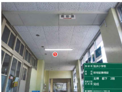
新設照明器具 (LED) 点灯試験で完成
