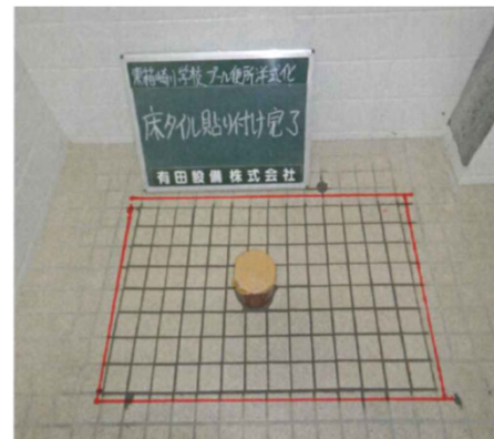
タイル仕上げ
