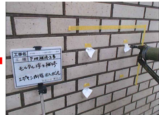
専用の機械でエポキシ注入
