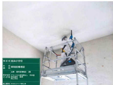
照明器具の取付の準備
