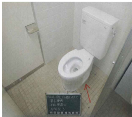
器具取付完了
