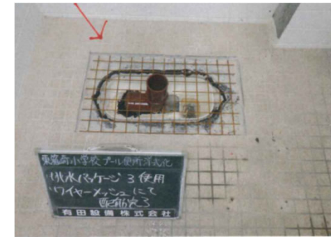
カット完了後ワイヤー メッシュ取付補強
