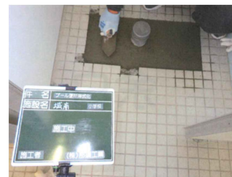
コンクリート、モルタル打設
