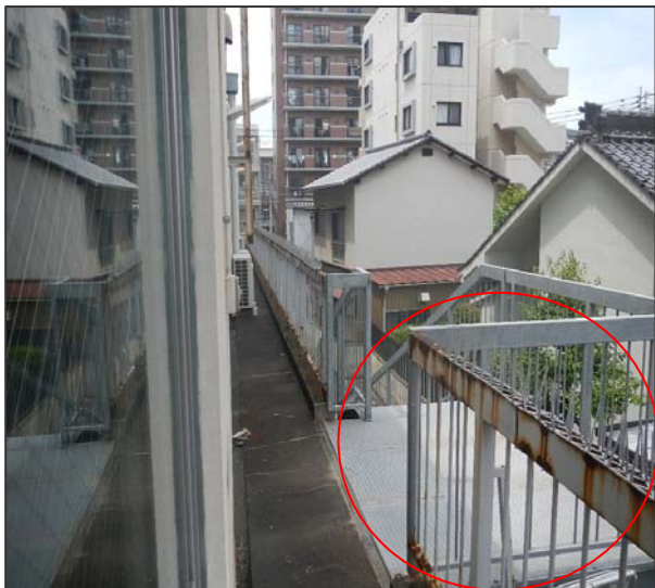
ベランダ鉄骨手すり部
