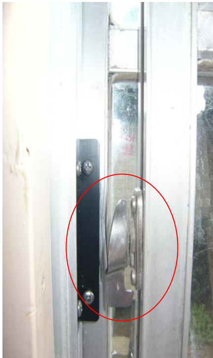
③クレセント(開状態)での引き戻り状況
