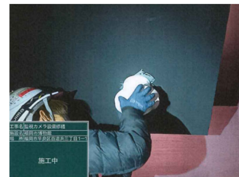
新設カメラ施工状況
