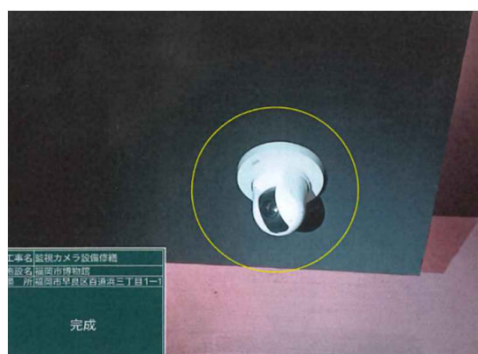
新設カメラ完成
