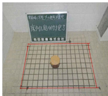
タイル仕上げ
