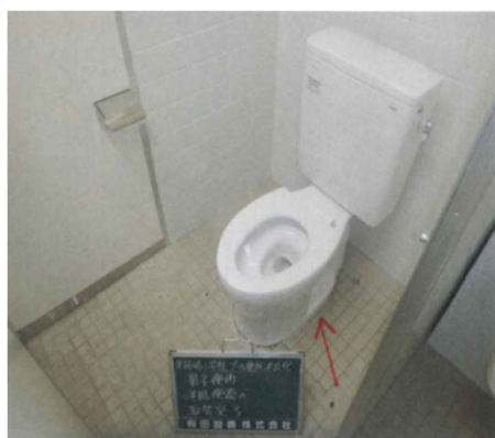
器具取付完了
