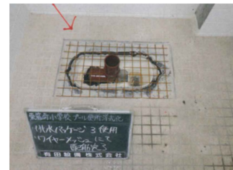
カット完了後ワイヤー メッシュ取付補強
