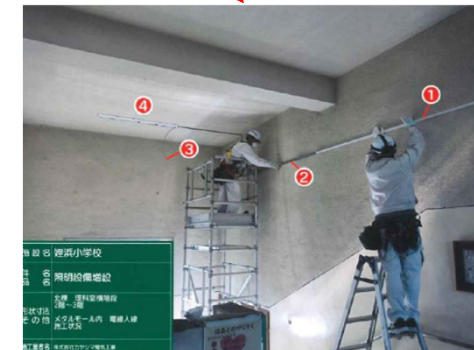
照明器具取付のための 配管設置
