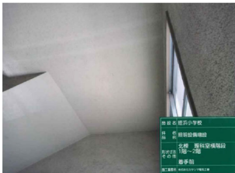
照明設備 取付前
