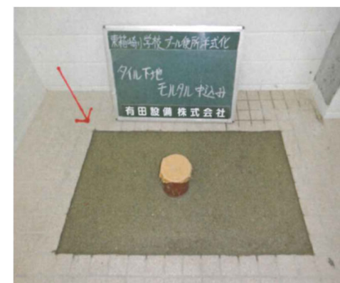
モルタル仕上げ
