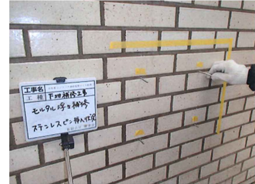
ステンレスピンを挿入
