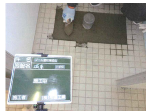
コンクリート、モルタル打設
