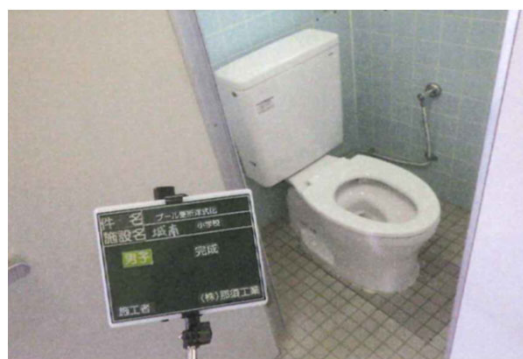
器具取付完了
